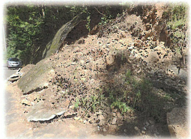
神湊財産区有林内の災害現場
