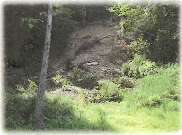
葉津地区内の災害現場
