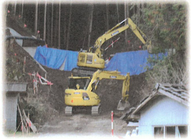
下八日市地区内の治山工事現場
